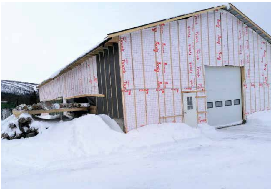
Det nye sagbygget mangler kledning, og har enn så lenge et provisorisk tømmerbord. Men produksjonen er allerede i gang. Foto: Privat.
