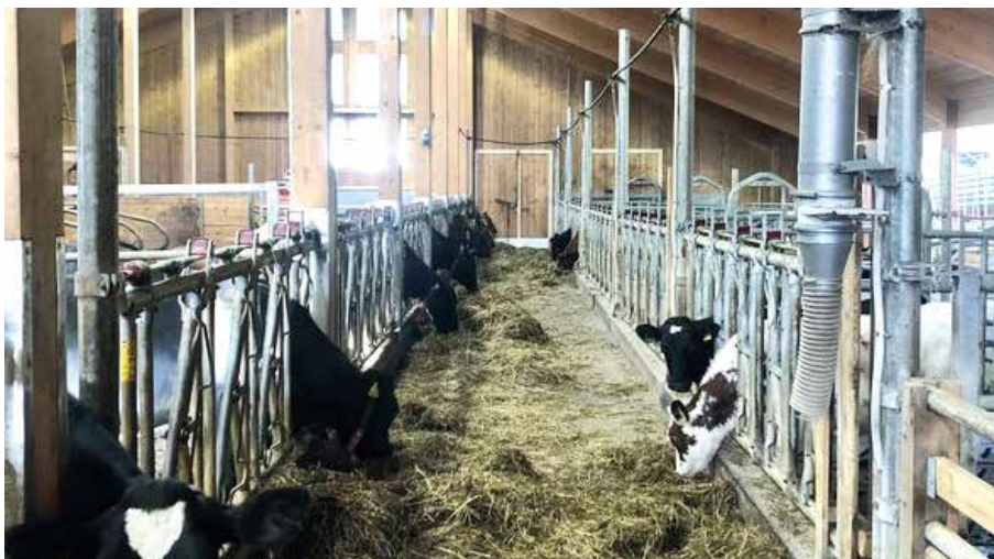
Trefjøs bygt i heiltre massivtrelement på Hansbruket i Gloppen, Vestland med 35 liggebåsar for kyr. Fjosen har naturleg ventilasjon med luftegardiner med automatisk styring.
