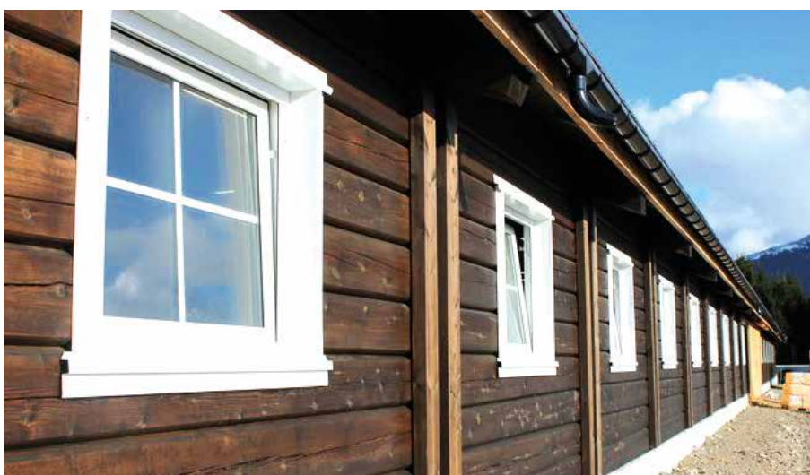
Kyr med Norges beste utsikt på Halså, Møre og Romsdal. Fjosen er bygd med heiltreveggar i laft av lokalt tømmer og lokale leverandørar og har naturleg lufting, mange vindu og godt med dagslys.
