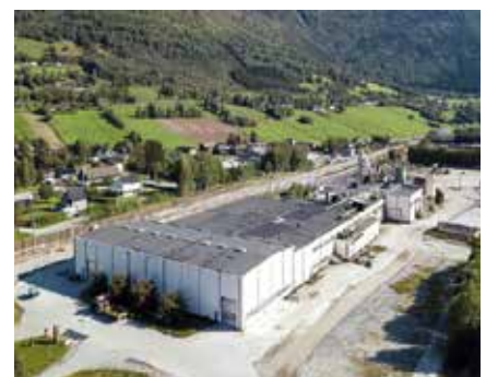
Det gamle Forestia-anlegget i Gudbrandsdalen blir element- og precutfabrikk.
