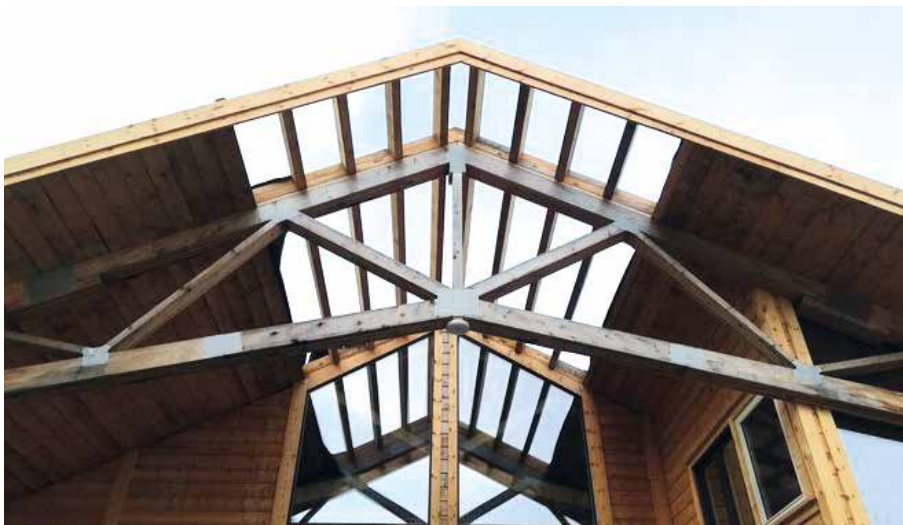
Stryn, Vestland: Sauefjøs i slepplaft av furu kjerneved frå Riska Sagbruk. Taket levert av Frøholm Sag i naturleg tørka lokal gran.
