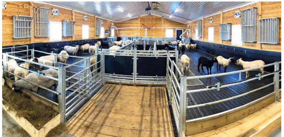
Sauefjøs i heiltrelement, Rauland, Telemark. Godt inneklima og kort byggetid på grunn av elementmontasje.
