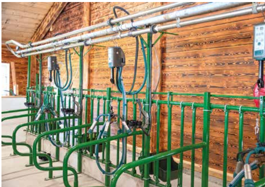
Mjølking: Her er verken mjølkegrav eller –robot. Kyrne går lause i fjøset, men blir stengde på bås når dei skal mjølkast.
