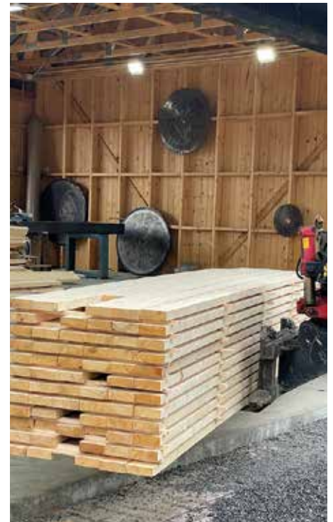
Sortering og stabling av trelast kan no foregå innandørs i det nye saghuset.
